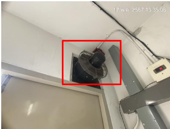
พัดลมดูดอากาศภายในห้อง MBD
