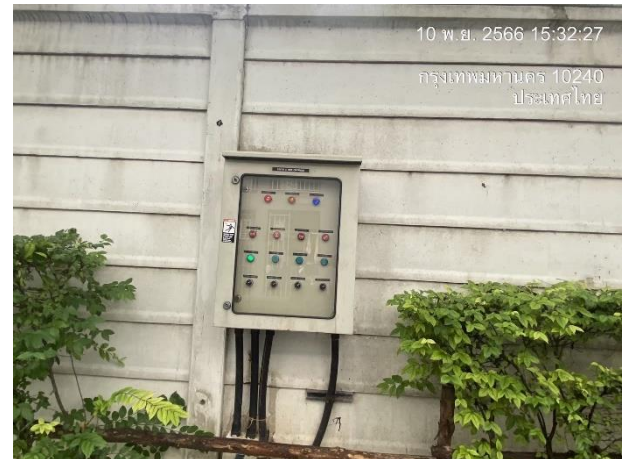
ตู้ควบคุมของระบบบำบัดน้ำเสีย B 1
