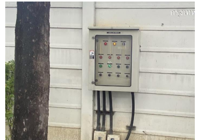
ตู้ควบคุมของระบบบำบัดน้ำเสีย B 2
