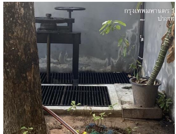
ภาพที่ 2-23 ตะแกรงครอบบ่อพักน้ำสุดท้าย
