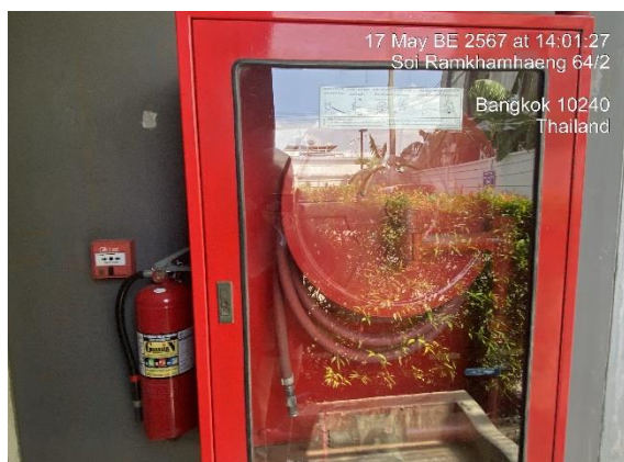
ตู้เก็บสายฉีดน้ำดับเพลิงและอุปกรณ์ดับเพลิงพร้อมป้ายแสดงวิธีการใช้
