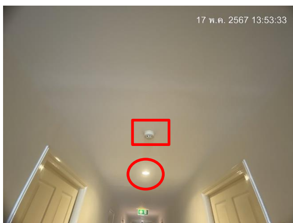
ไฟฟ้าส่องสว่าง และเครื่องตรวจจับควันภายในอาคาร
